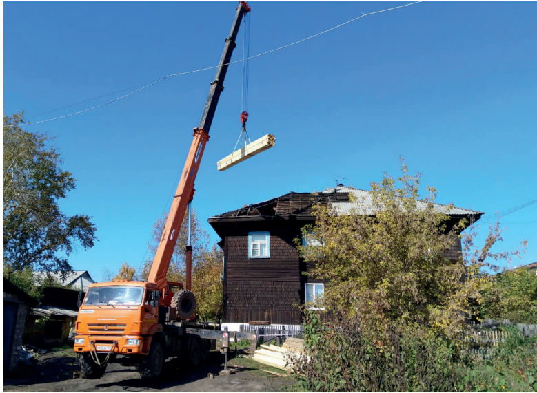
Ремонт дома в микрорайоне Стекольный в Тулуне
