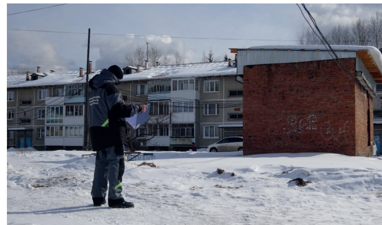
ФКР провел обследование многоквартирных домов в Байкальске, чтобы определить их дальнейшую судьбу
