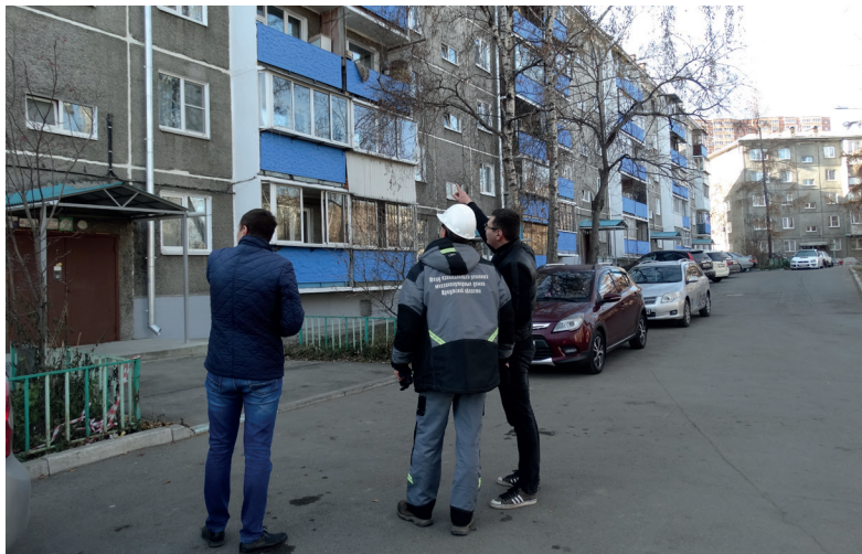
Капитальный ремонт МКД пришел в Иркутскую область надолго и всерьез
