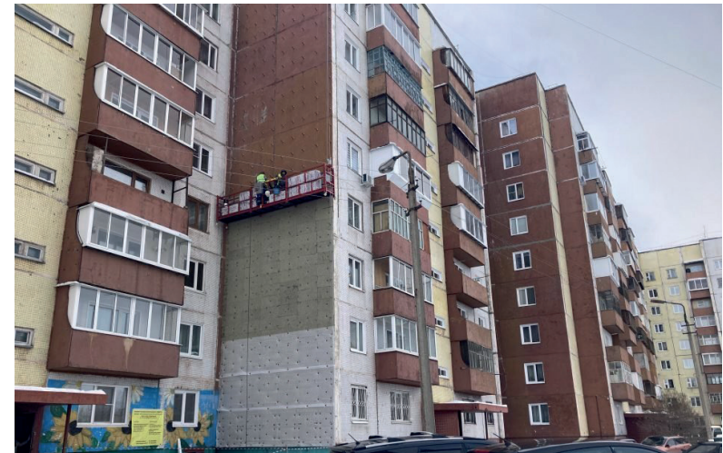
В Братске многоквартирные дома ремонтируют массово
